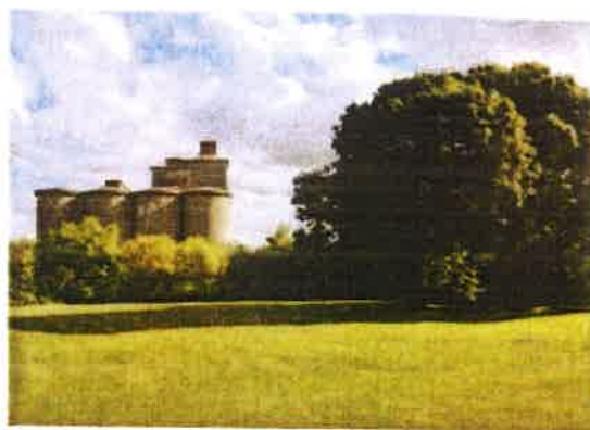
Parc des Crêtes RD 161
